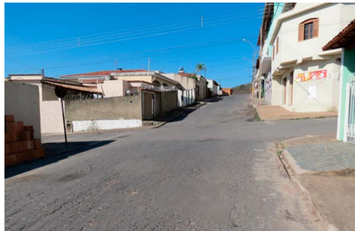
Falta de sinalização na Rua Orozimbo
