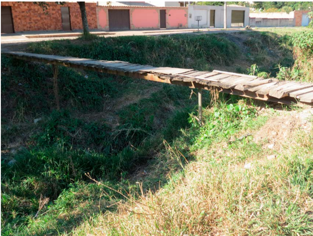
Ponte sobre ribeirão na Avenida Doutor Walter Mendes Nogueira
